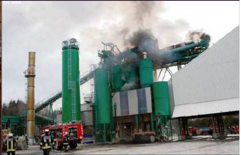
Quelle: szbz: 20.3.2008_Sindelfingen (BW)
